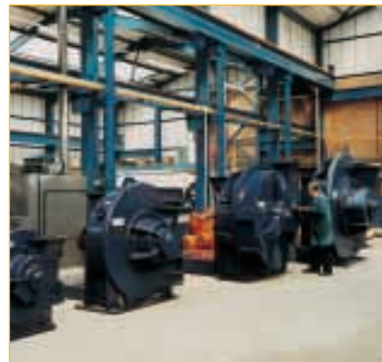
11, 16, 18 u. 20A bei der Inspektion
